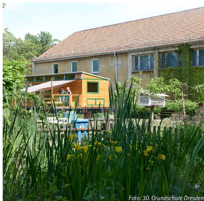
Foto: 30. Grundschule Dresden
